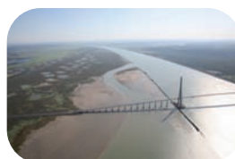
Mesures d'accompagnements de Port 2000 : Creusement du nouveau méandre amont, 2005
