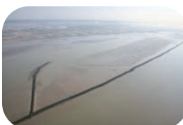
Mesures d'accompagnements de Port 2000 : Création d'un épi favorisant le développement d'un banc sablo-vaseux
