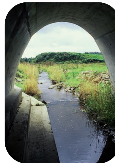
Ouvrage hydraulique équipé d'un passage à loutre sur l'autoroute A89
